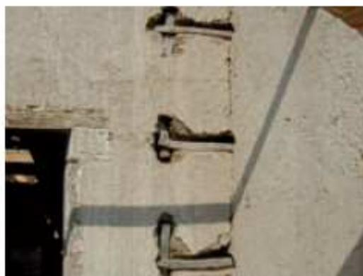
Fig. 3.20. Sistema di ammorsamento tra murature ortogonali realizzato con travi lignee disposte all'interno del corpo murario e ad esso vincolate con l'uso di болгони.
