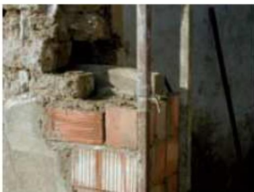
Fig. 3.19. Sistema di ammorsamento della muratura in terra cruda esistente con nuovi stipiti in laterizio attraverso ancoraggi lignei inseriti nel corpo murario.
